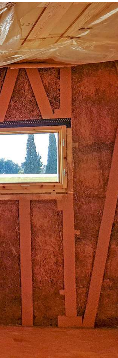
La palla d'arròs es pot fer servir com a material de construcció / LUCIA BLASCO
