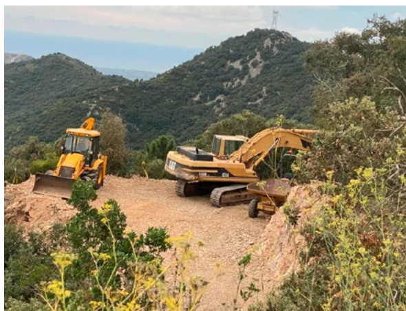
Les obres d'una nova central eòlica han començat a la zona del Vedat del Pany, a les muntanyes entre el Baix Camp i el Priorat
