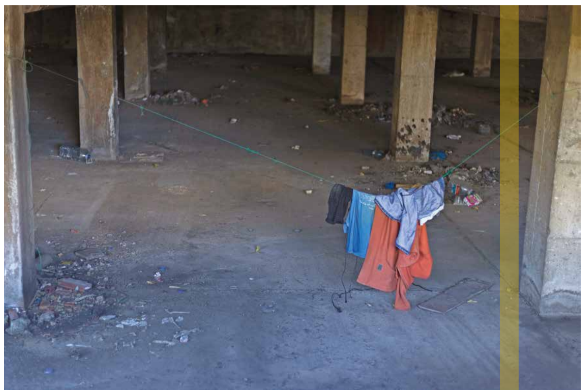
A La Garrofera (Benimaclet, València) hi viuen prop de deu persones migrants sense cap servei energètic ni sanitari. Les condicions de barraquisme, infrahabitatge i okupació d'habitatges dificulten l'accés als serveis bàsics per a tindre una vida digna.
