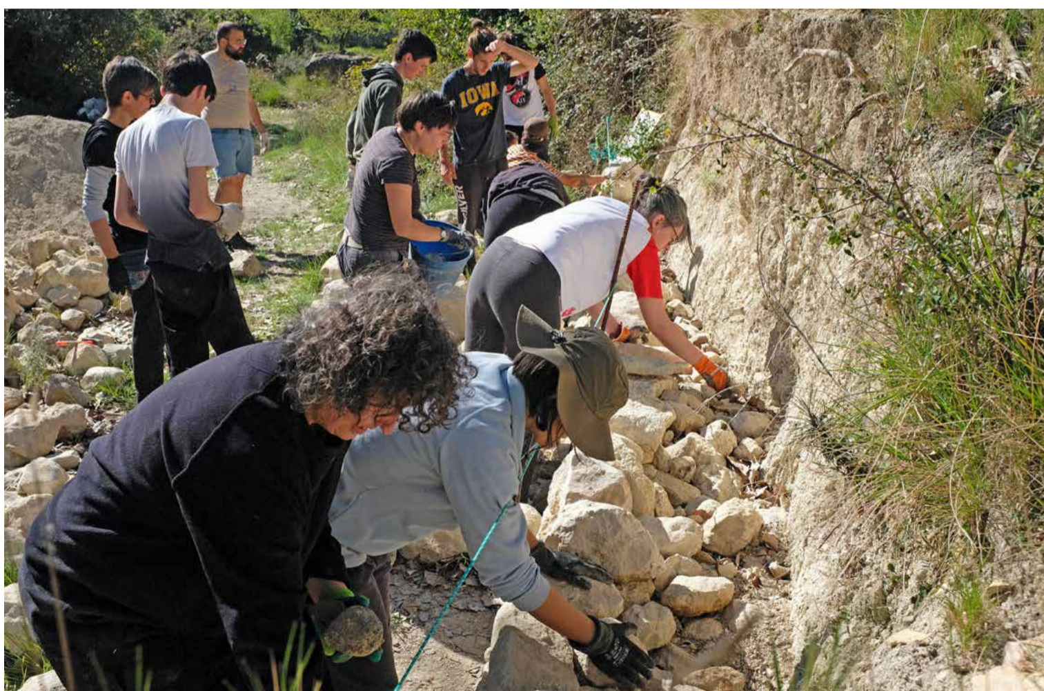
Taller de construcció de pedra en sec, una de les moltes activitats que es duen a terme al Mas del Potro
