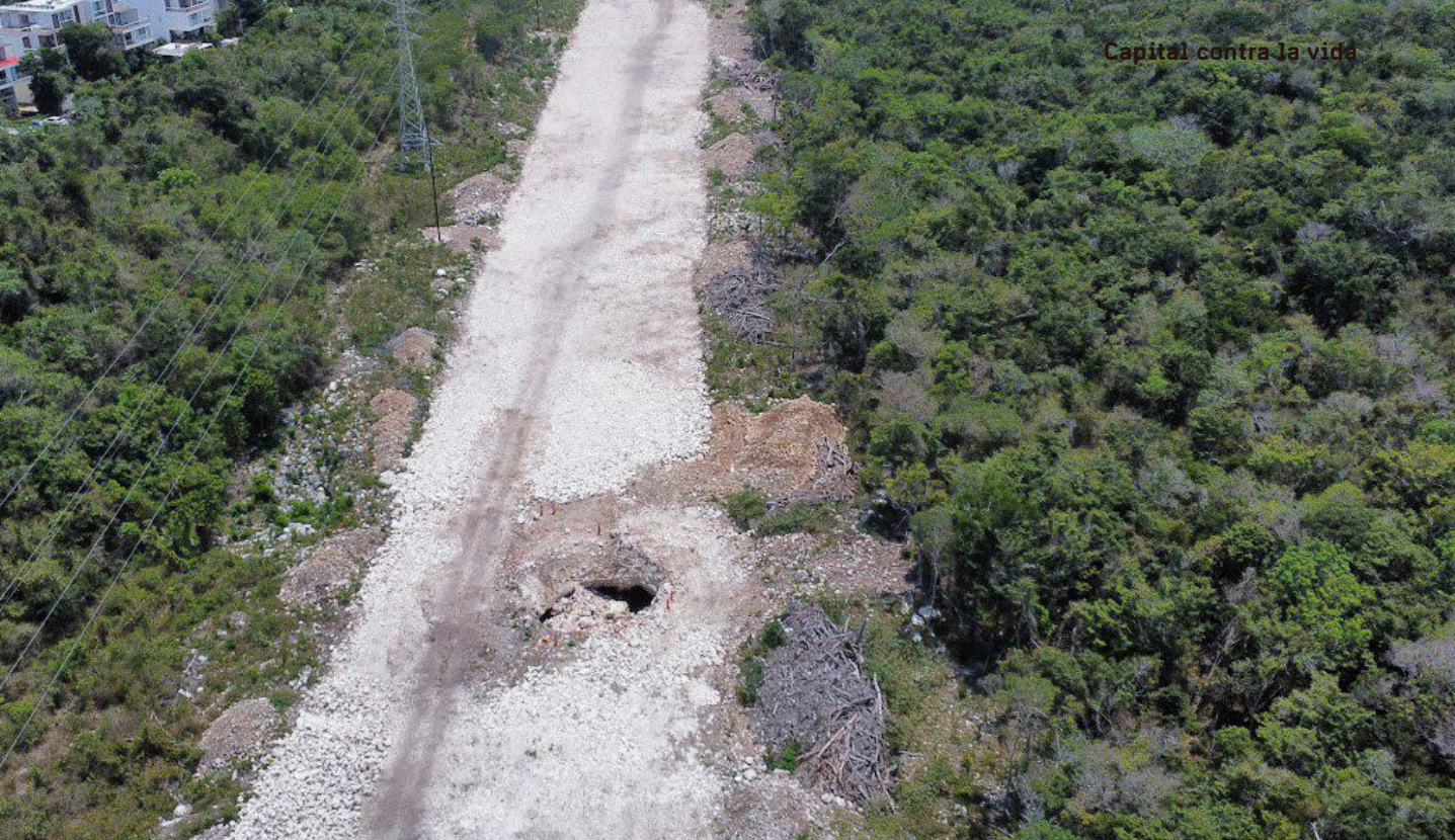
Part de la base de la via col·lapsada del tram 5 del Tren Maia ELIAS SIEBENBORN
