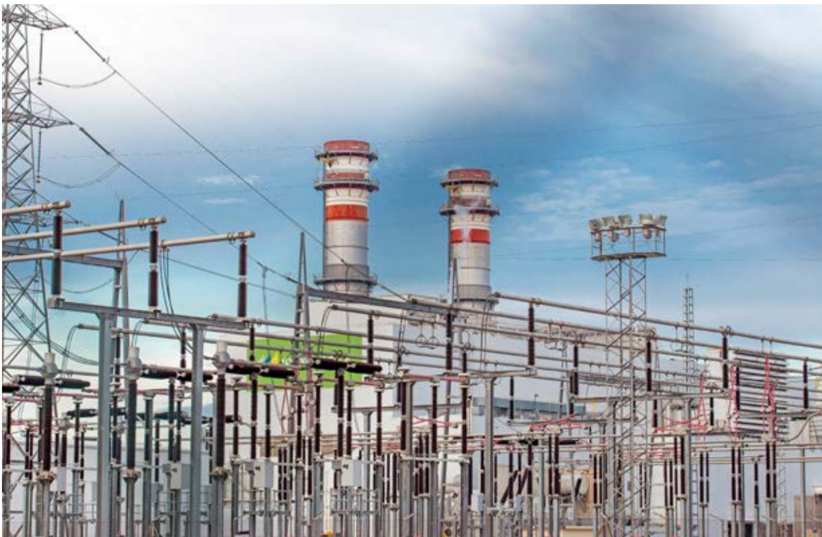
Instal·lacions del polígon del Serrallo de Castelló / DÍDAC RAMÍREZ
